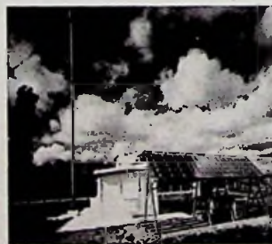
Zonnepanelen leveren de energie voor een (50 watt) radiobaken, St. Giron (Gironde, Frankrijk).
